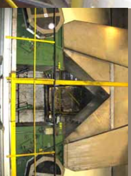
Kun vaatimuksena on jatkava 90° läpi vuorokauden, kaksoasennus housu-pukkeilla mahdollistaa toisen koneen huoltamisen toisen toiminnassa.
