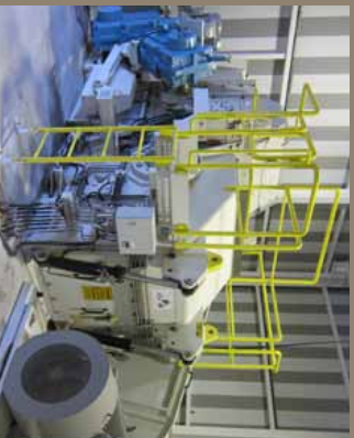
Prosessointilaitokset ovat sisäpuolelta puhdaita ja huoltoa varten hyvin varustettuja. Huuhtaus- ja kaiteet ovat laitteissamme kiinteitä rakenteita.
